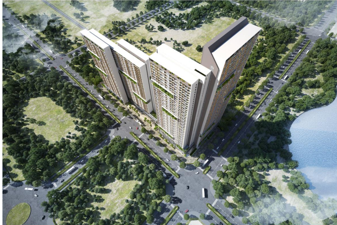
DỰ ÁN CHUNG CƯ CAO TẦNG CT6 - ANLAND
